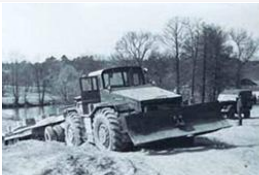
Испытания тягача МАЗ-538. 1961 г.
